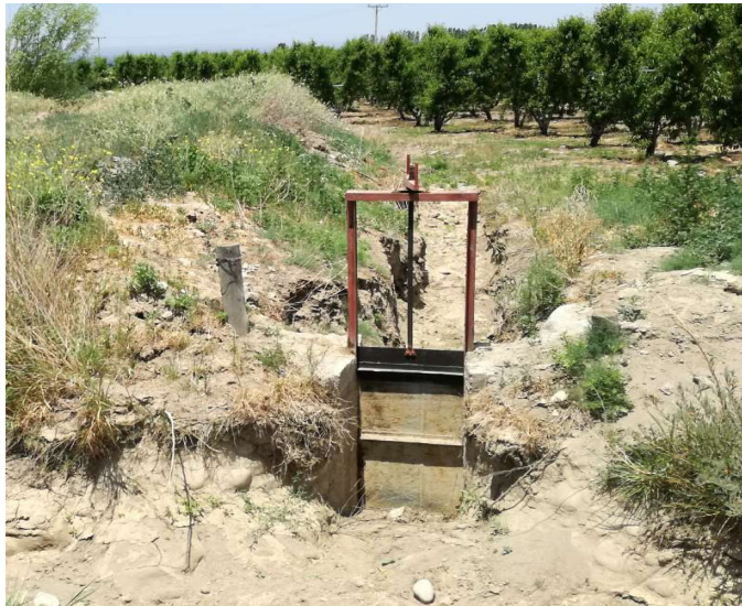
Cauce en tierra y toma de riego a gravedad.
