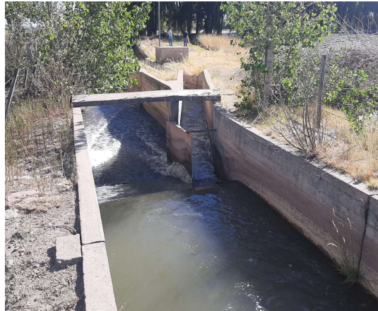
Canales revestidos. Obras distribución
