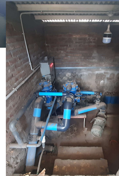
CABEZAL DE RIEGO
